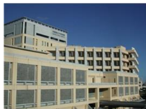
中部病院 (日本形成外科学会認定施設)
