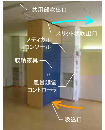
図6-1-6 吹出口・吸込口の形状と配置
